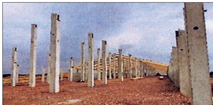
Der Dachstuhl wird gebaut. Foto: P3N MARKETING
