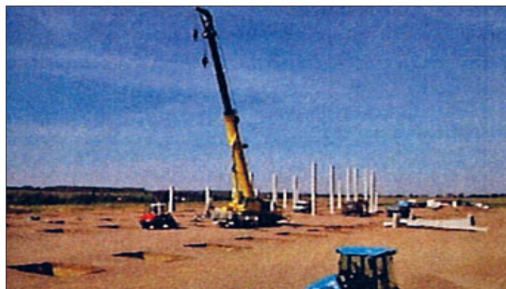
Stellen der Säulen, Foto: Genießergenossenschaft Sachsen eG
