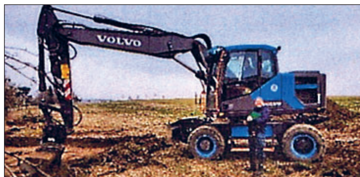
Start der Tiefbauarbeiten, Foto: Genießergenossenschaft eG
